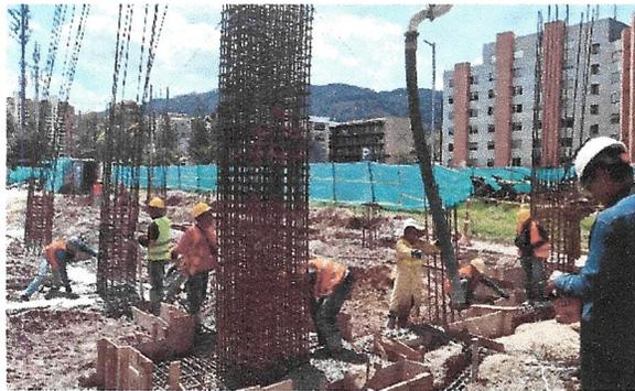
Fundida de 160 m3 de concreto de vigas y dados de cimentación
