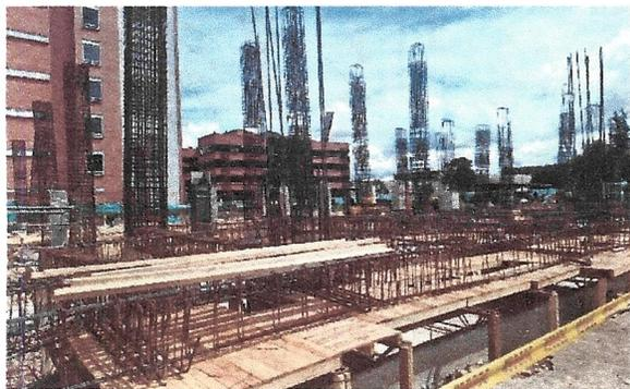
Armado de acero vigas y columnas
