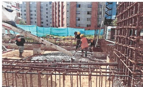
Fundida de concreto de placa cimentación
