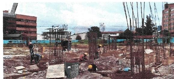
Armado de vigas de cimentación.
