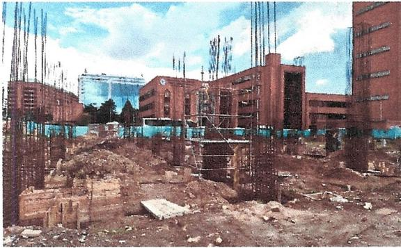
Armado de acero de columnas
