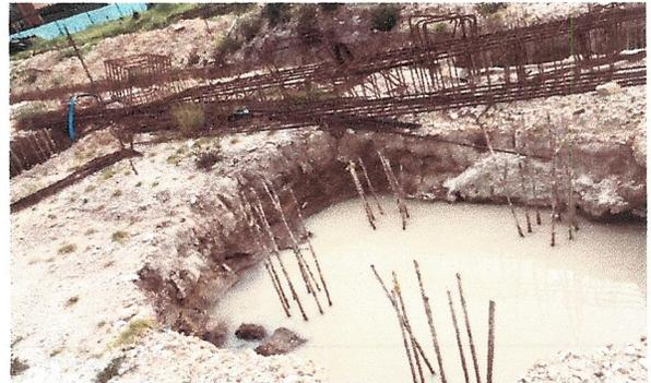
Corrosión en barras de refuerzo de pilotes y agua estancada
