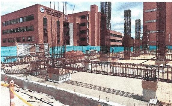
Fundida de concreto de placa de cimentación
