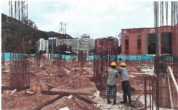
Armado de acero de columnas
