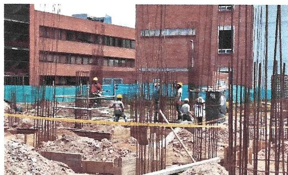
Armado de acero de columnas
