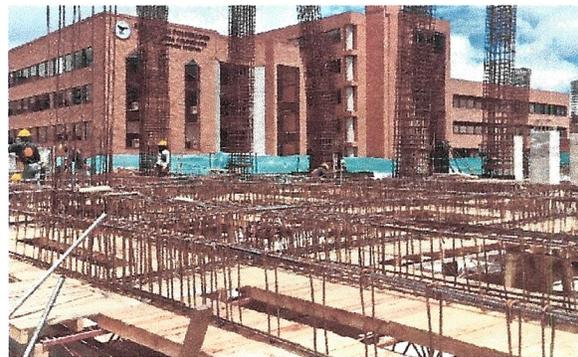
Armado de acero vigas y columnas
