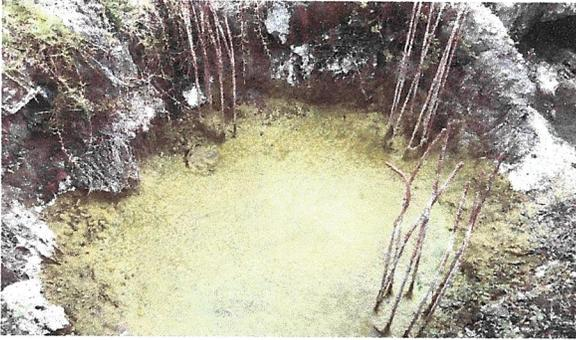
Eutrofización en la excavación y corrosión en barras de refuerzo de pilotes
