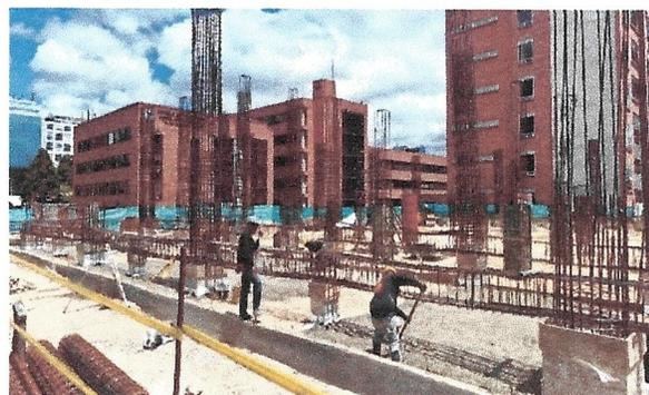
Fundida de concreto de placa de cimentación
