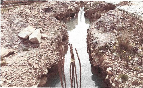
Corrosión en barras de refuerzo de pilotes y agua estancada
