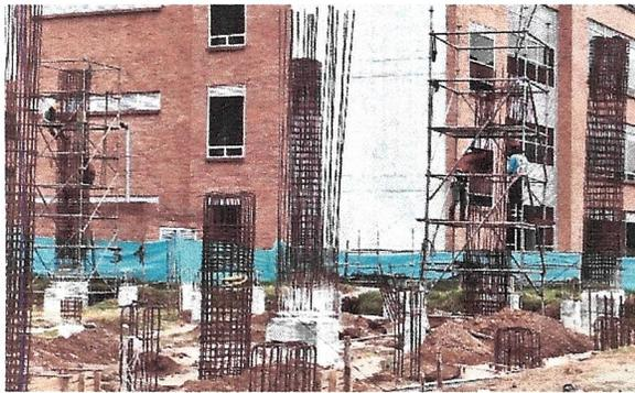
Armado de acero de columnas
