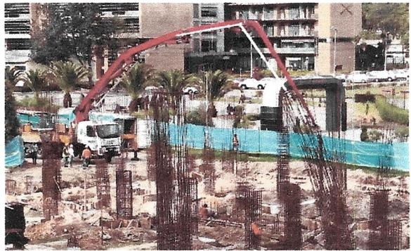
Fundida de 100 m3 de concreto de vigas y dados de cimentación
