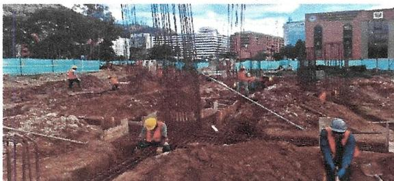
Excavación manual y armado de vigas y dados de cimentación
