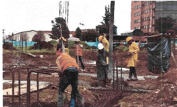
Fundida de 144m3 de concreto de vigas y dados de cimentación
