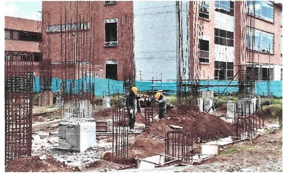
Desencofrado y curado de columnas
