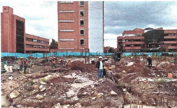
Solado y levantamiento topográfico
