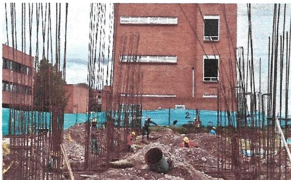
Excavación manual y armado acero de columnas
